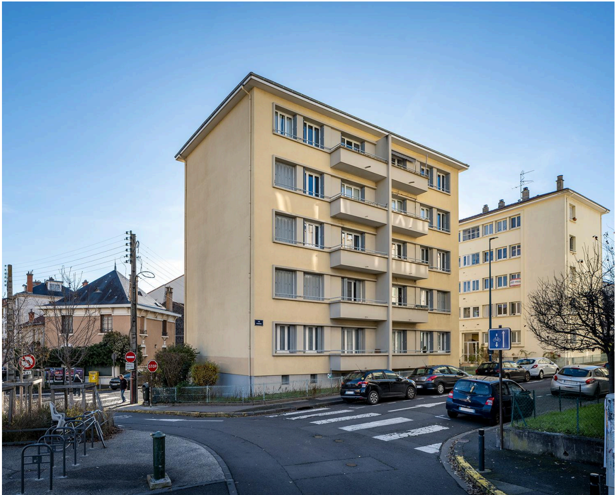
Immeubles du lotissement Bonhomme et Palazzi
