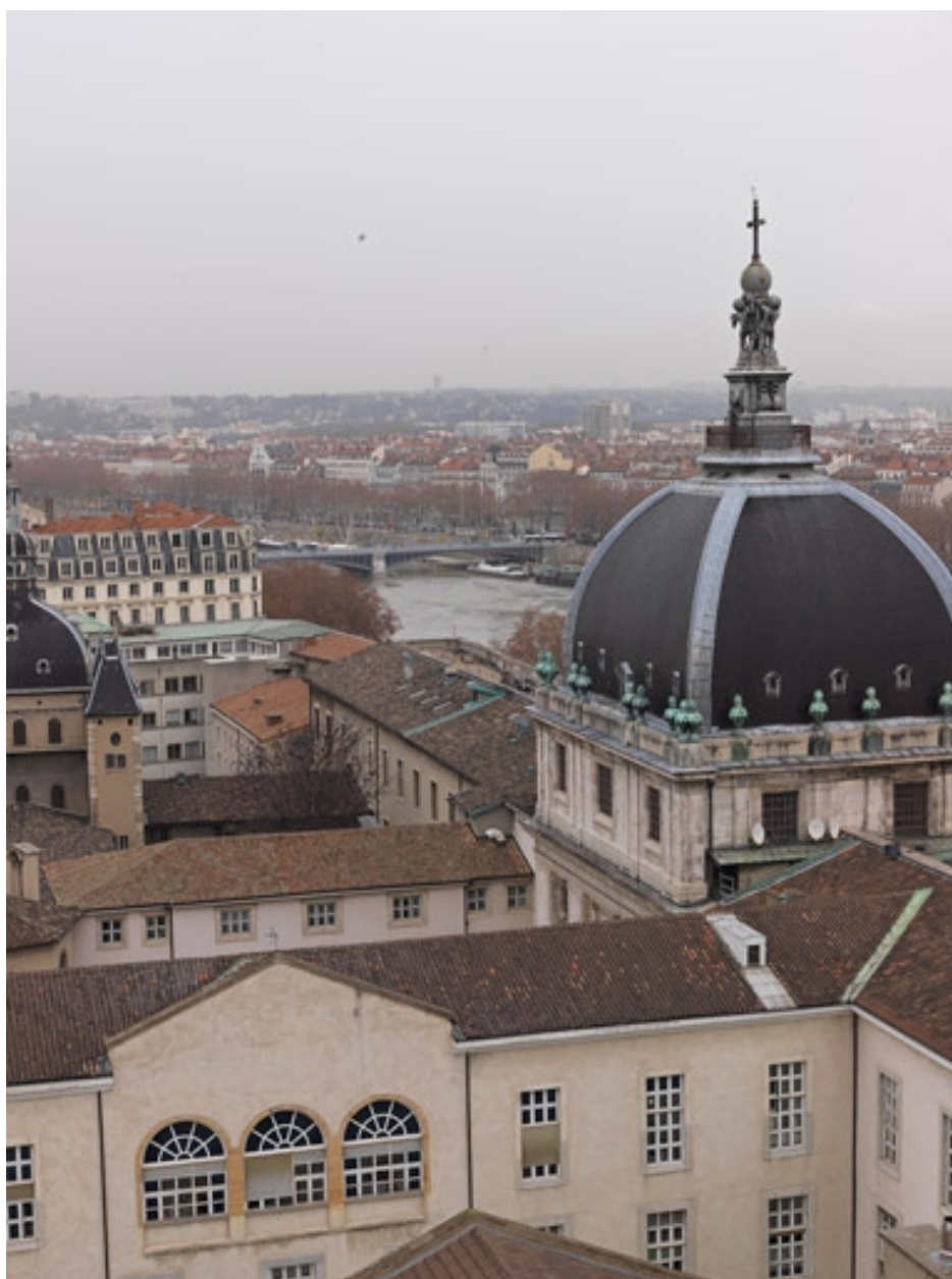
Vue depuis le dôme Pascalon au sud-ouest. Les bâtiments E, G, K et le dôme Soufflot
