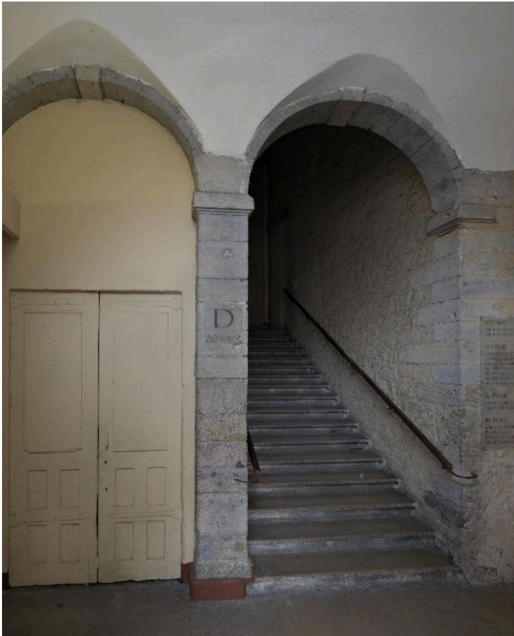
Escalier D, 1ère volée
