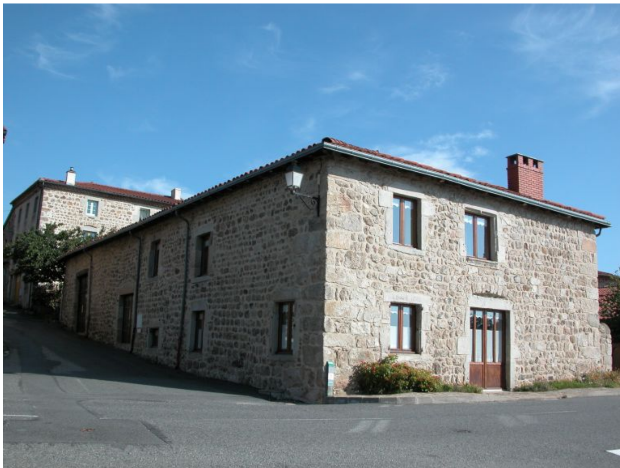
Vue d'ensemble du logis de trois-quarts arrière gauche.
