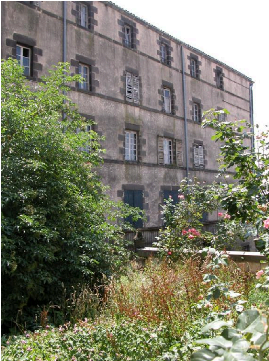
L'élévation nord avant démolition (photographie chercheur).
