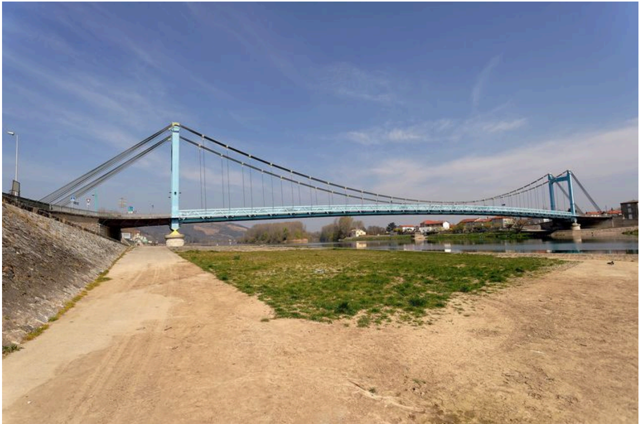
Vue générale, face aval (depuis la rive droite)
