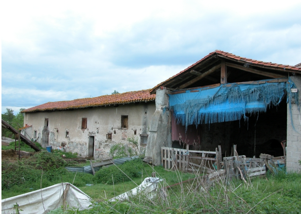
Vue arrière de la grange-étable.
