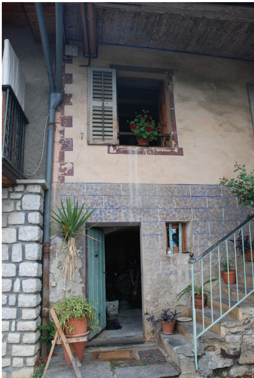
La Saussa, ferme isolée (2018 YH 240). Détail de l'enduit peint.
