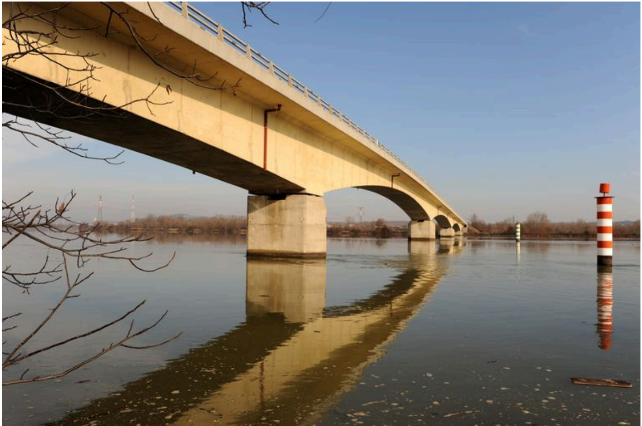
Vue partielle, de côté, face aval (depuis la rive droite)
