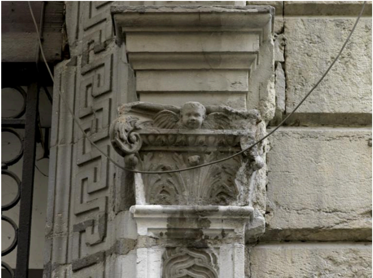
Portail : chapiteau ornant le piédroit droit
