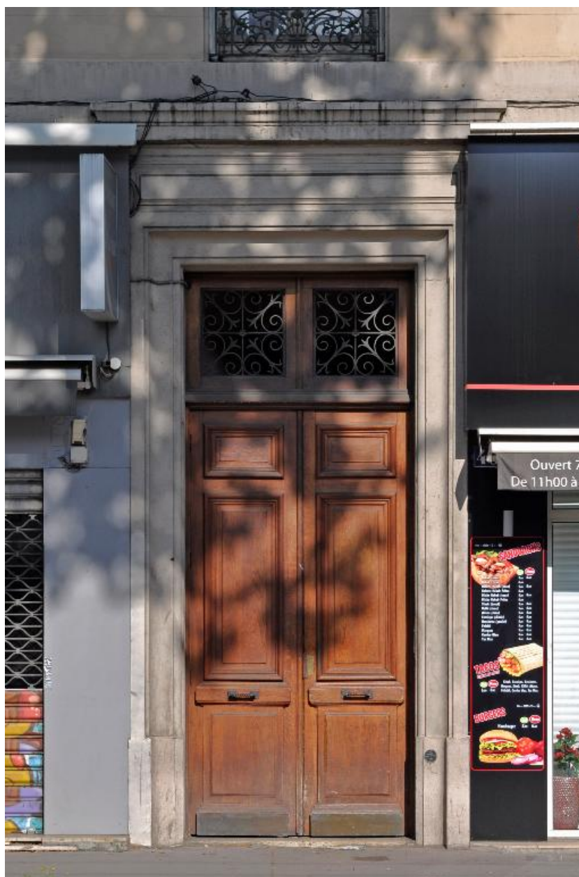
Vue rapprochée de la porte d'entrée
