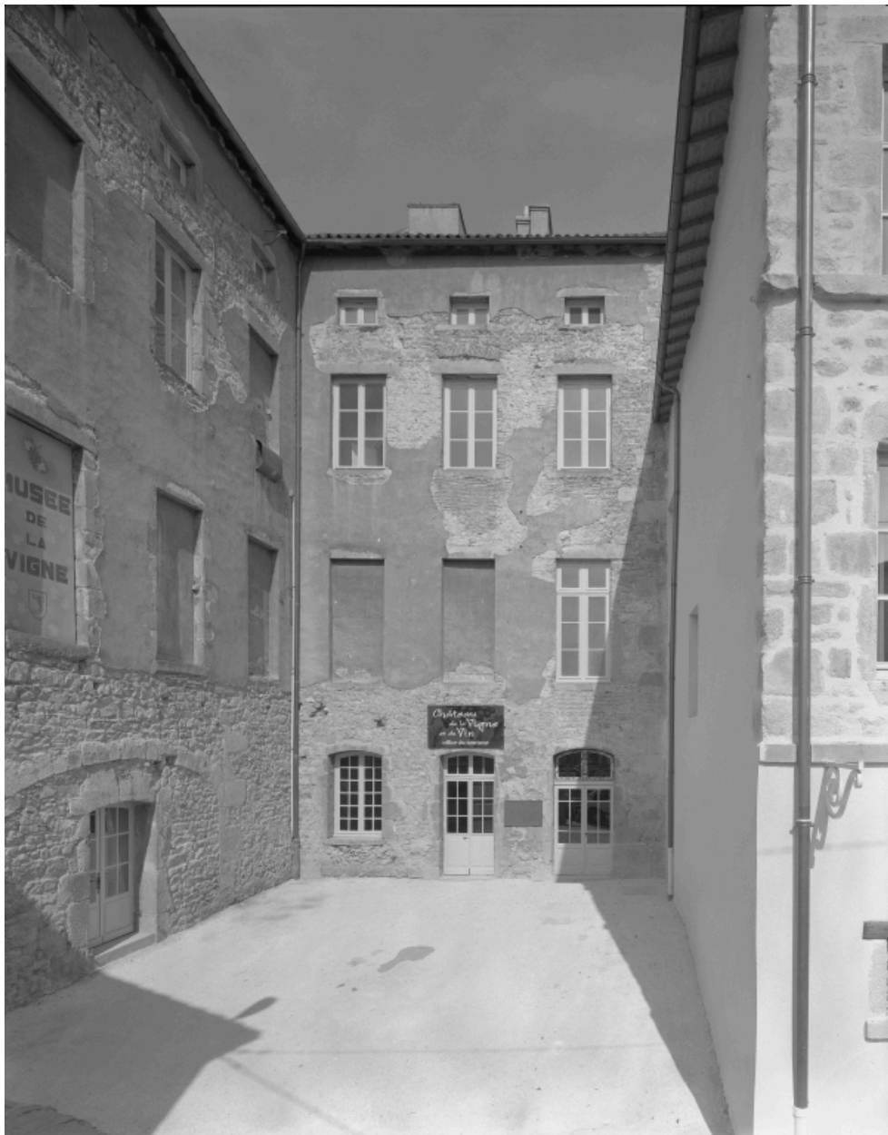
Vue de la façade de l'entrée donnant sur la rue des Martyrs de Vingré, du nord.
