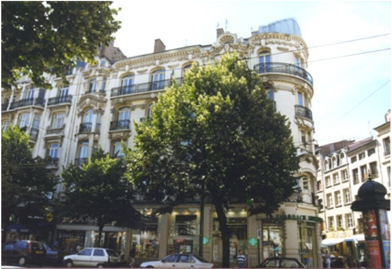
Vue d'ensemble, angle de l'avenue de la Libération et de la rue des Martyrs-de-Vingré
