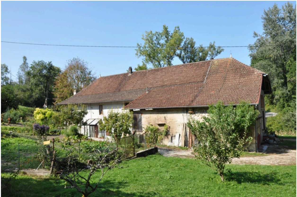
Vue générale du moulin Saucaz, façade sud
