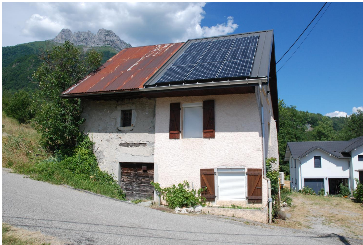
Les Jolis Coeurs, extrémité nord du rang : deux celliers dits "sartos" (2018 YI 172, 173).
