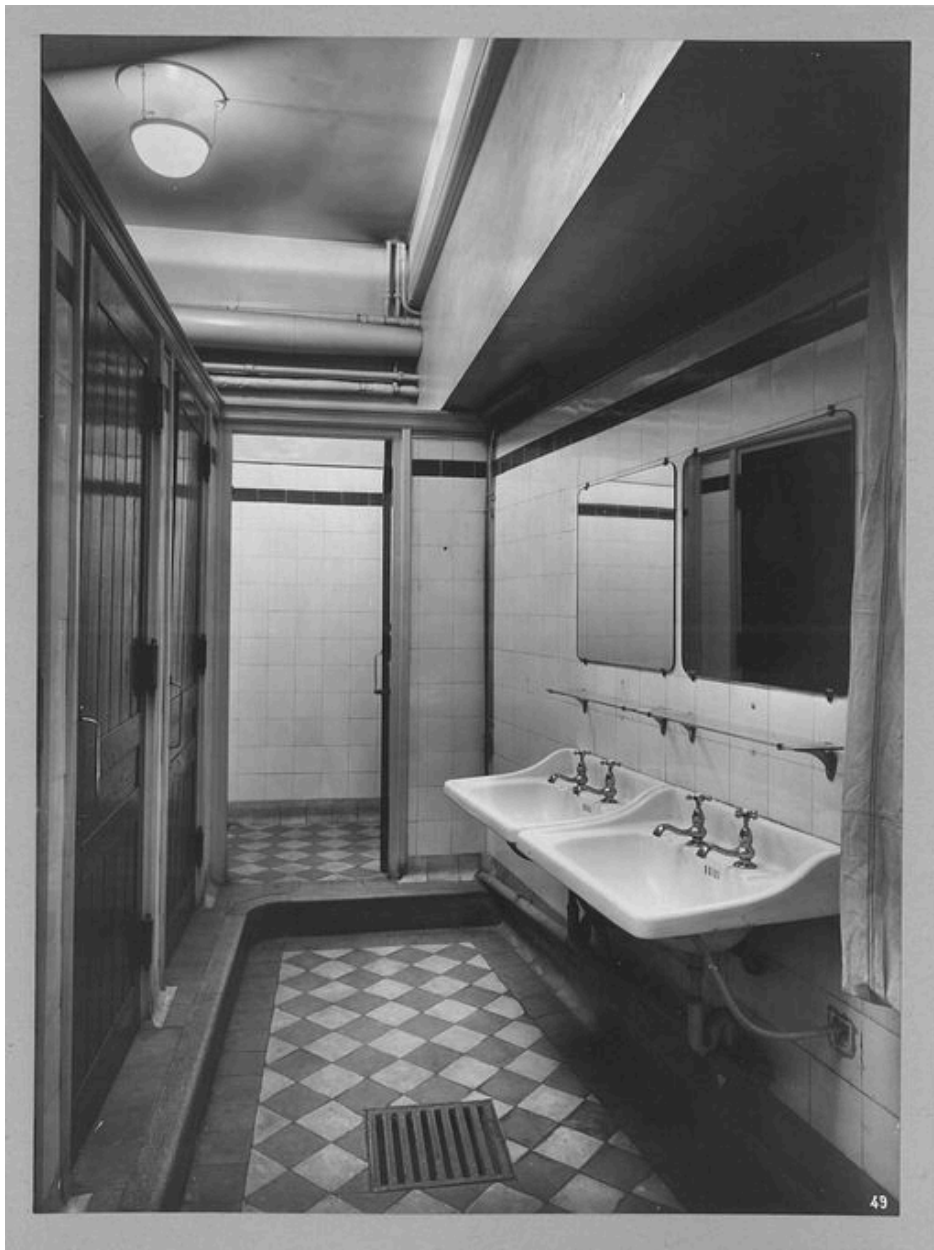
Vue des installations sanitaires, en sous-sol (1925) (Banque de France, PHAR, non coté, photographie).
