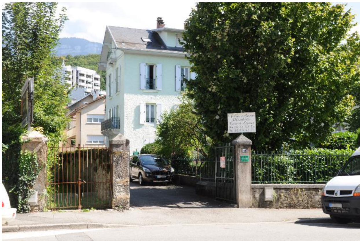
Vue d'ensemble depuis l'avenue de Marlioz
