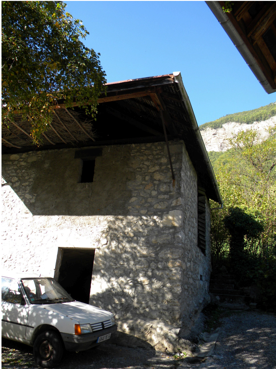
Vue du pignon sud sous un large débord de toit.
