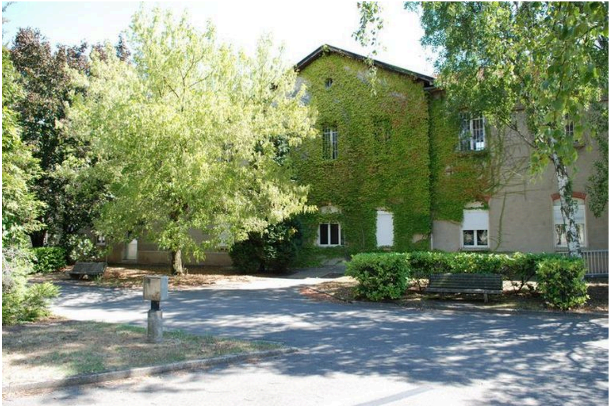
Bâtiment 456-457, façade principale (ouest), corps principal
