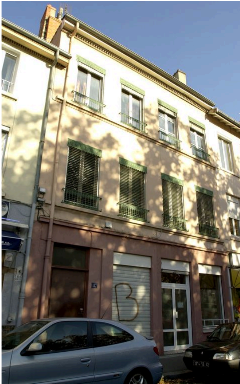
Vue générale depuis le sud-ouest
