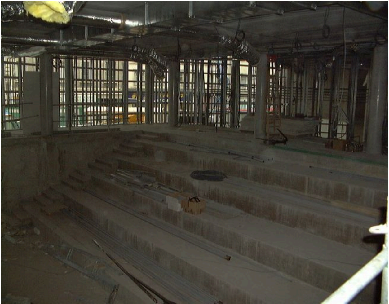
L'auditorium en cours de construction, 23 mars 2000
