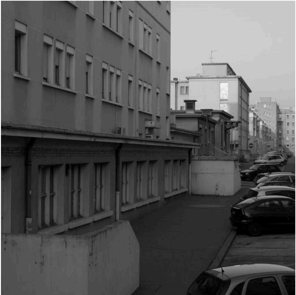
La limite nord du plateau médian : le bâtiment 10 et les baies éclairant la galerie souterraine, à l'arrière les bâtiments 8 et 7
