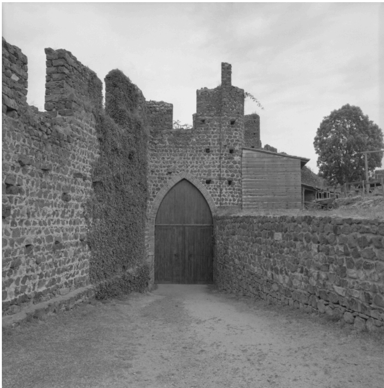
Vue intérieure du portail d'entrée, depuis le sud.
