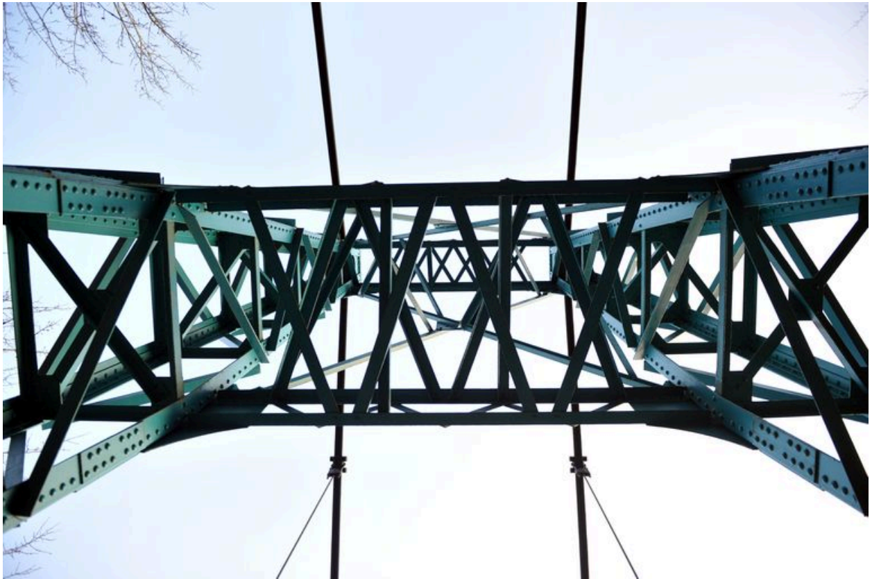
Pylône, vue partielle : structure métallique sommitale, de dessous
