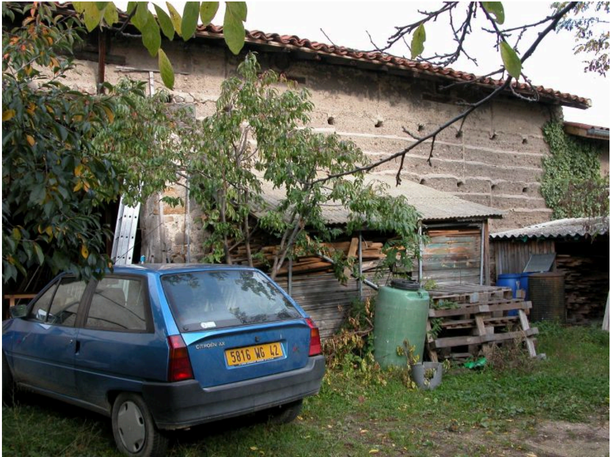
Vue partielle de la grange-étable.
