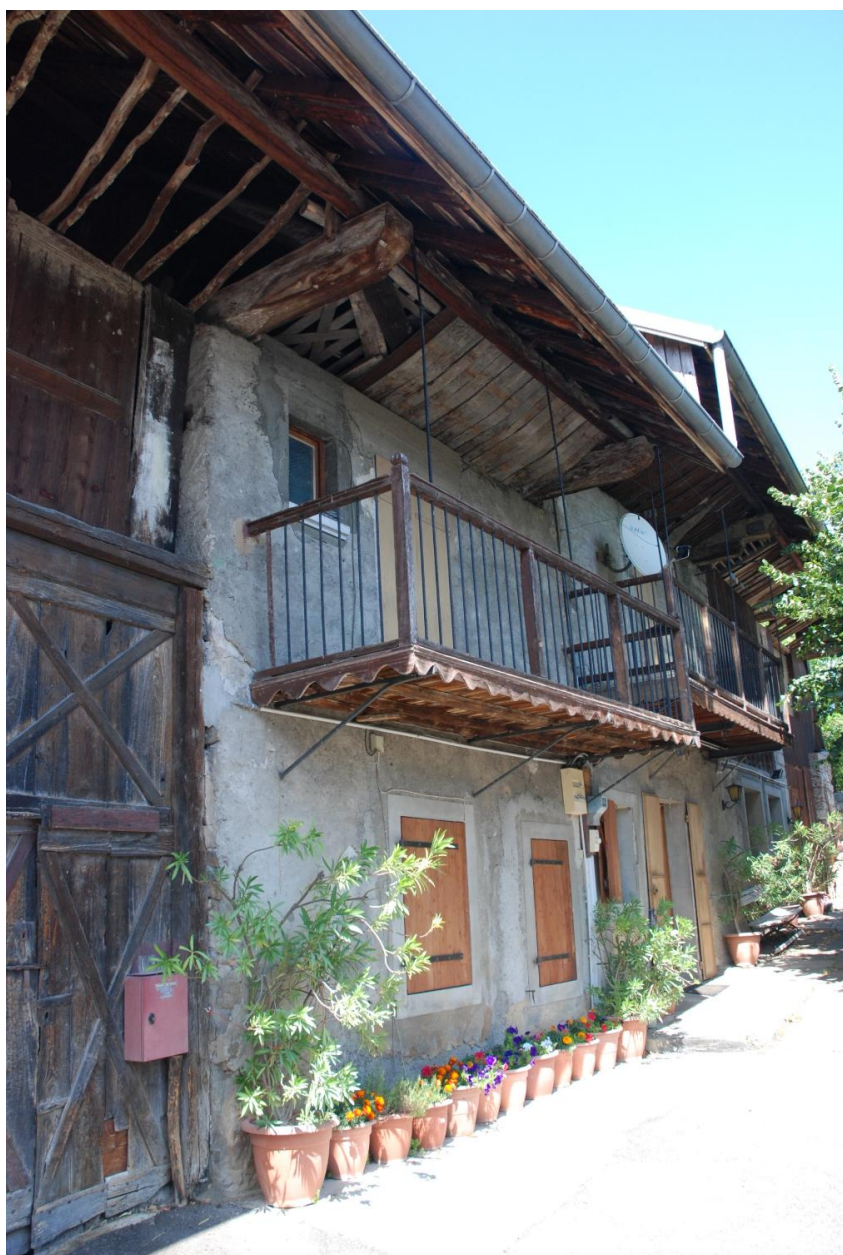
Maisons de vigneron (les Allues-dessous, 2018 YE 140).
