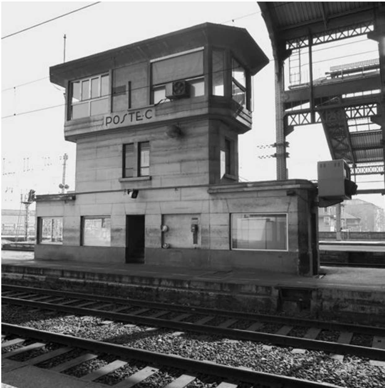
Le poste d'aiguillage C sous la grande halle
