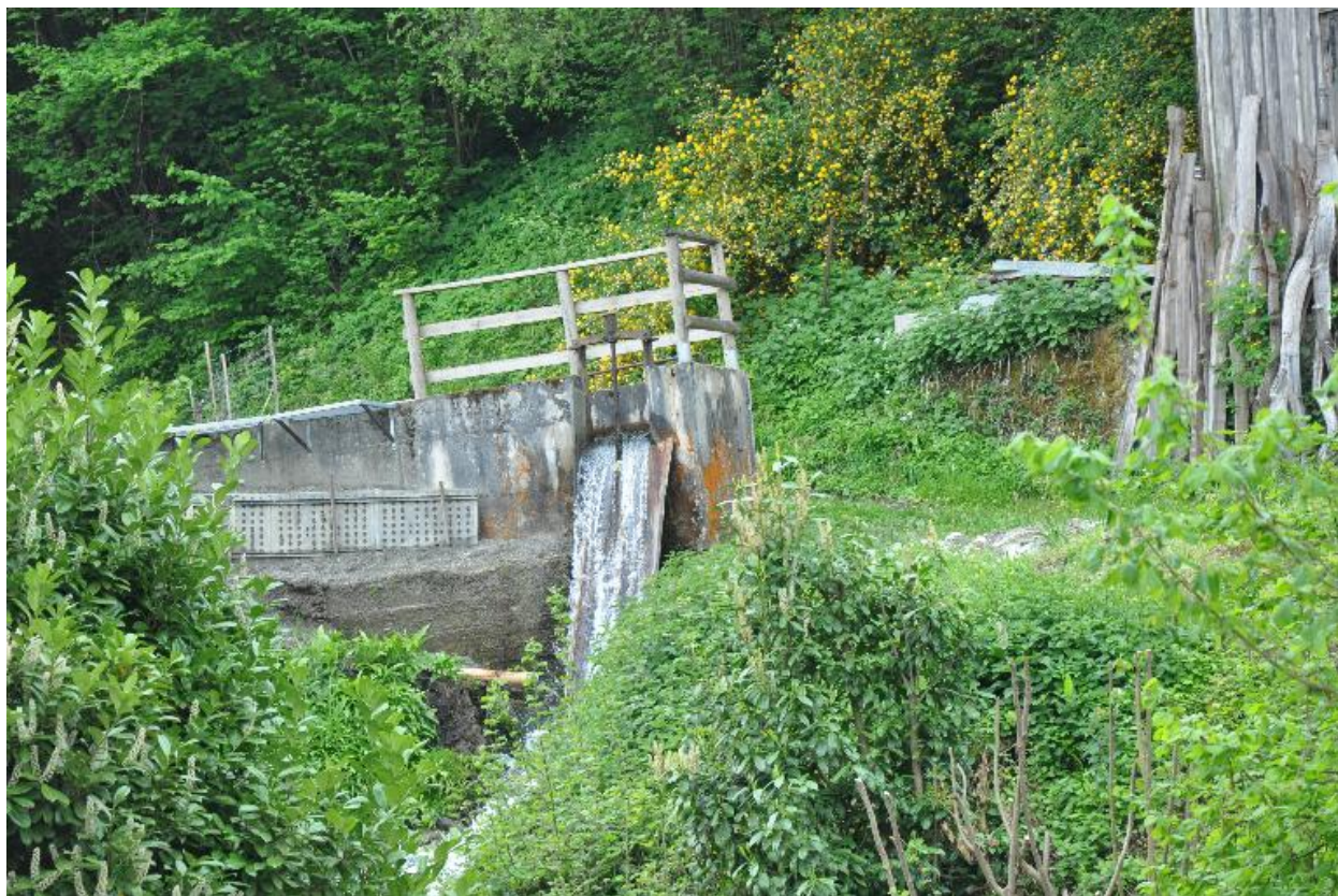
Vue du déversoir.
