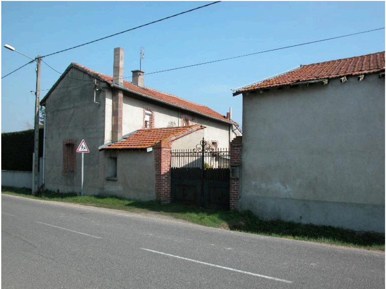
Vue d'ensemble de la ferme depuis la route.
