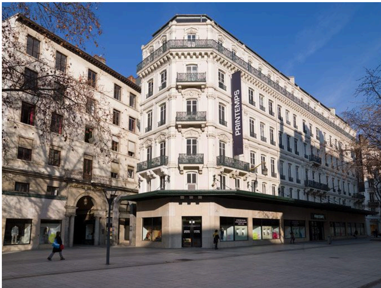
Vue générale des immeubles 34 à 38 rue des la République
