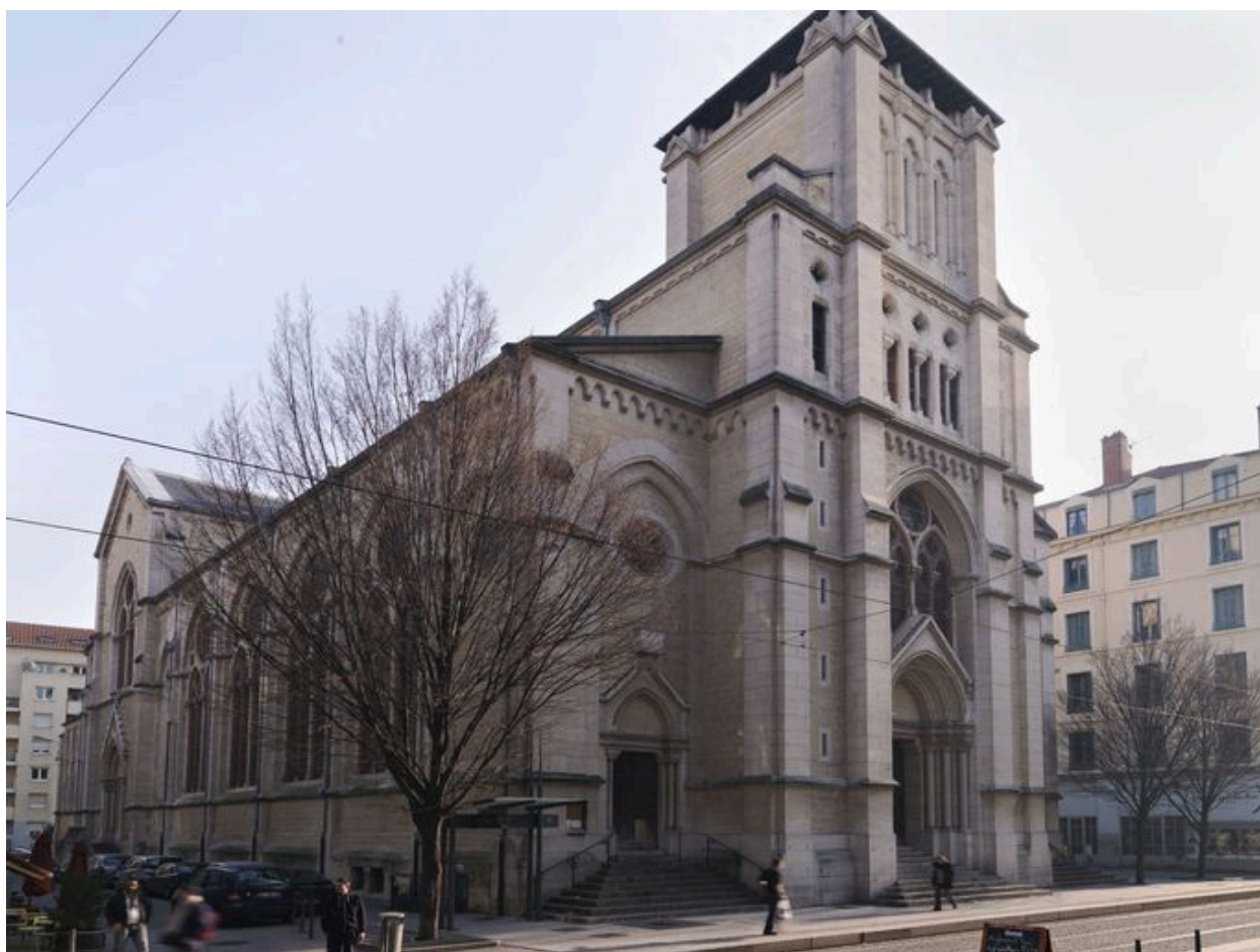
Vue des élévations ouest et nord.
