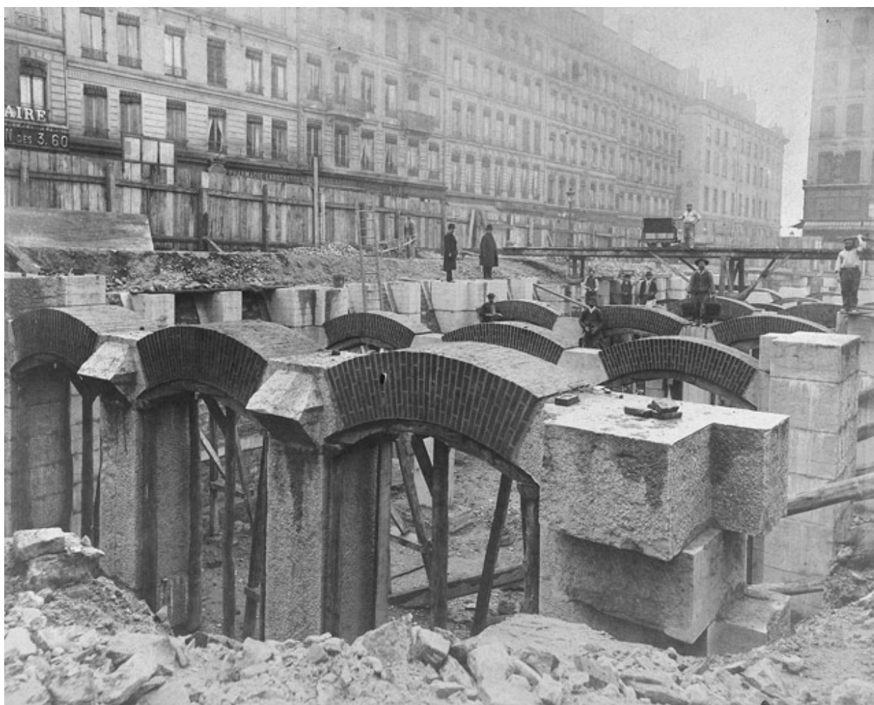
Le bâtiment A' en construction, angle de la rue de la Barre et de la rue Bellecordière. Photogr., [4e quart XIXe s.] (A. Musée des HCL. AF 37)
