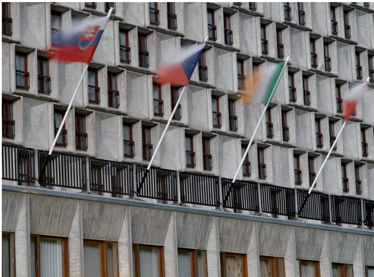
Détail des baies et des panneaux de ciment moulé de la façade principale
