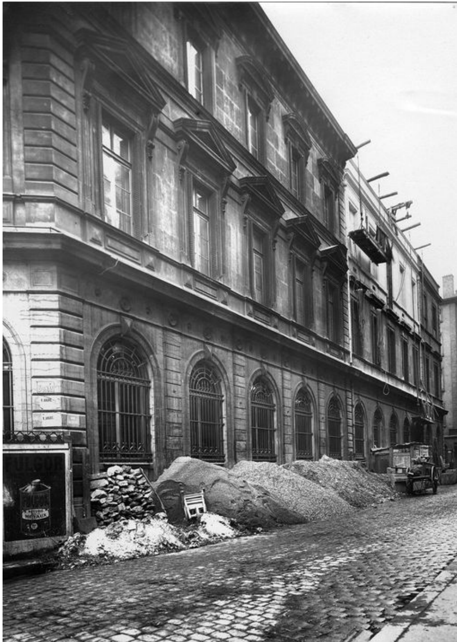
Vue du chantier de surélévation de la banque sur la rue Gentil, en 1922 (Banque de France, PHAR, non coté, photographie).
