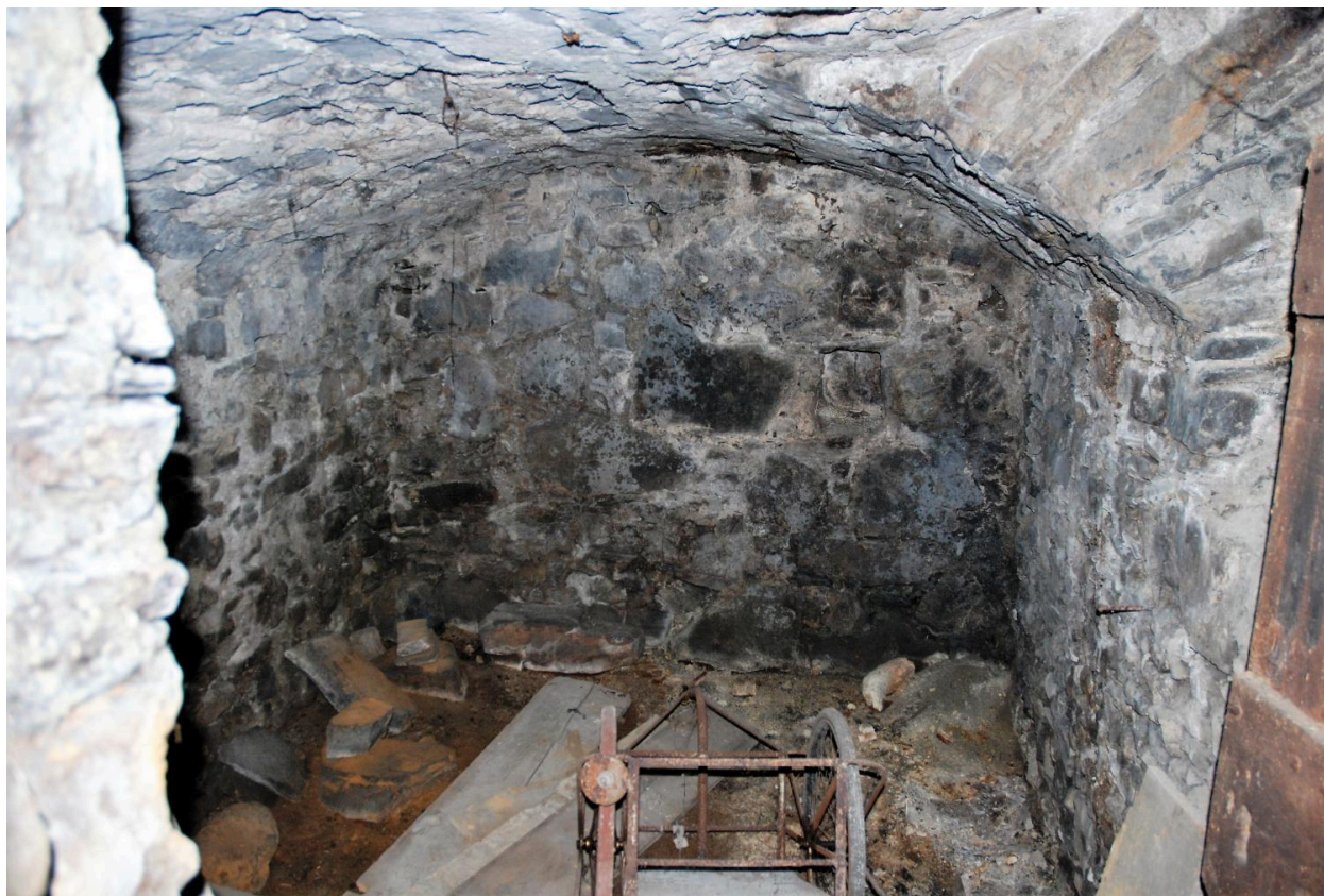
Maison, immeuble, 100 rue Louis Blanc-Pinget (2018 E1 1797). Vue intérieure de la cave jouxtant l'escalier d'accès.
