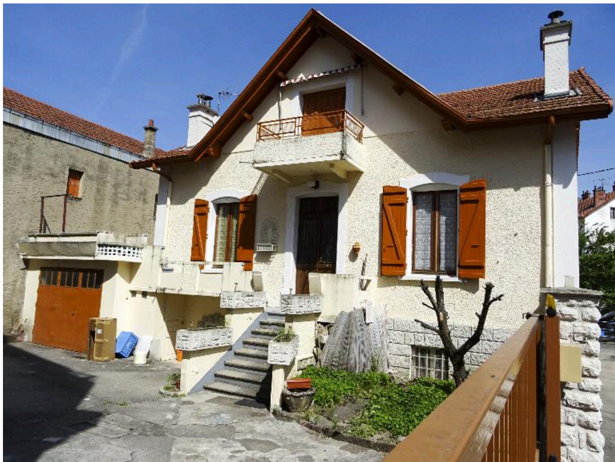
Façade principale (ouest)
