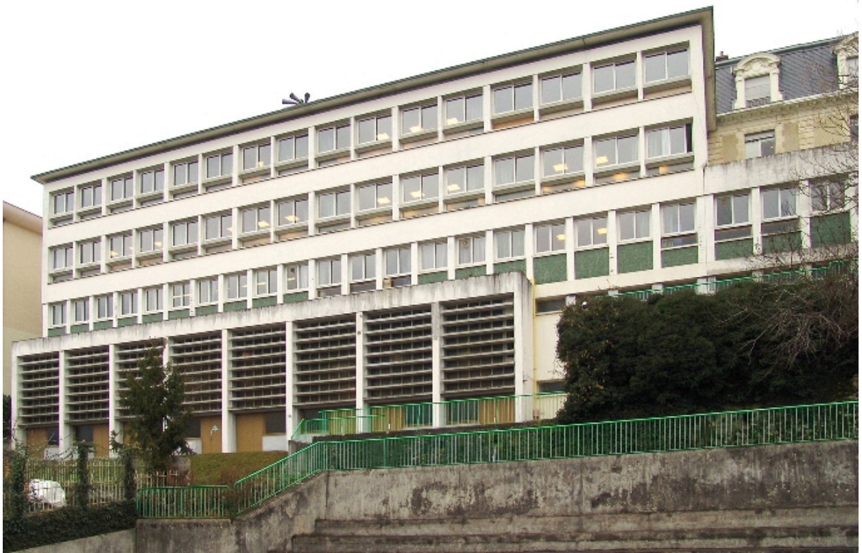
Bâtiment de 1962 : façade sur jardin, partie nord
