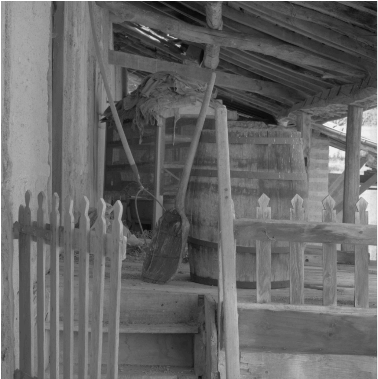
Premier ensemble. Bâtiment sud-est : aître située contre l'élévation sur cour, pelle à grain, tonneau et "chaizière".
