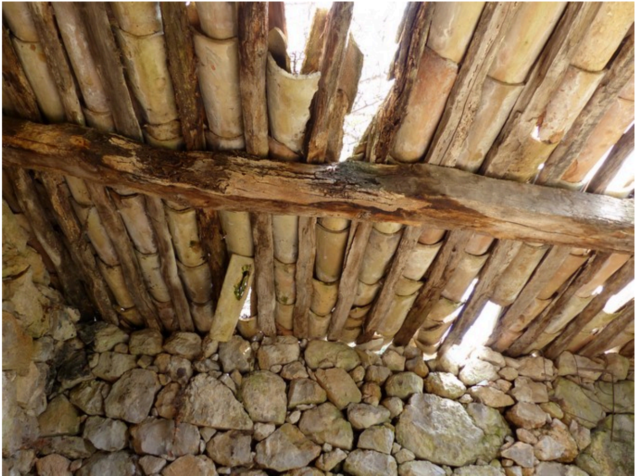
Charpente à pannes, tuiles sur quarts.
