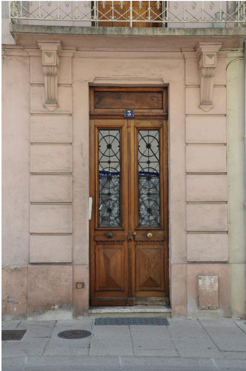
Porte d'entrée, façade est
