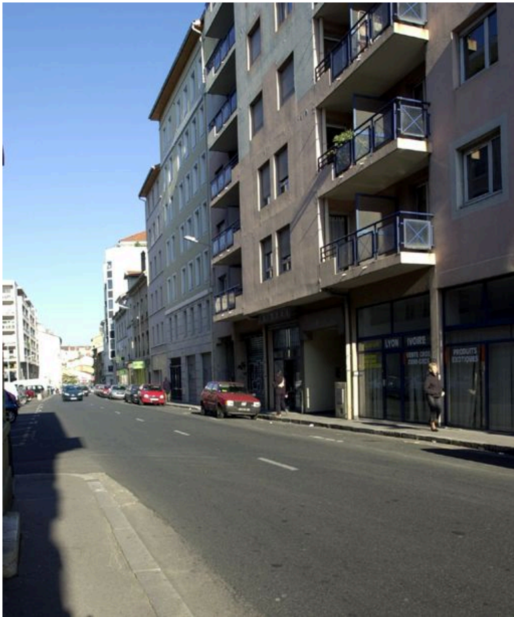
Vue vers l'ouest depuis le 136 grande rue de la Guillotière
