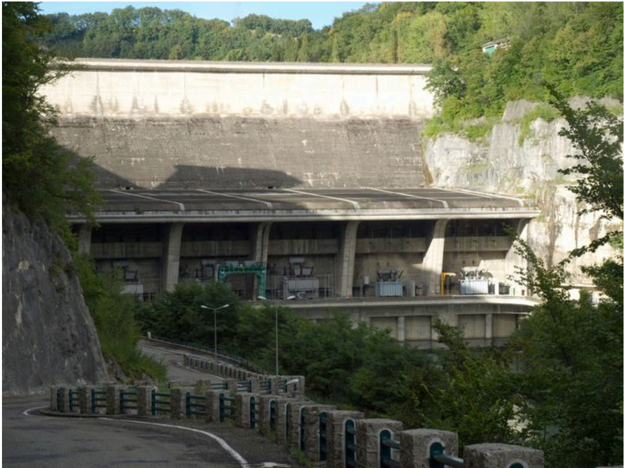
Vue générale du pont amont du barrage, face amont (depuis la rive gauche)
