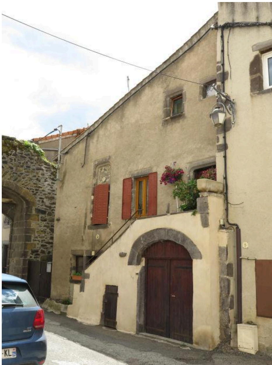
Escalier avec mur d'échiffre englobant une descente de cave : Châteaugay, 3 rue du Château
