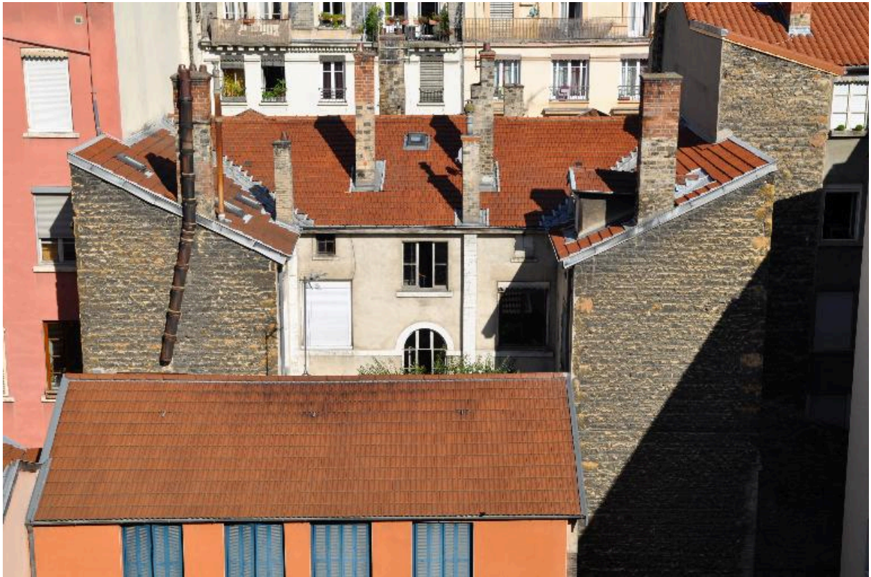
Vue générale de l'élévation postérieure
