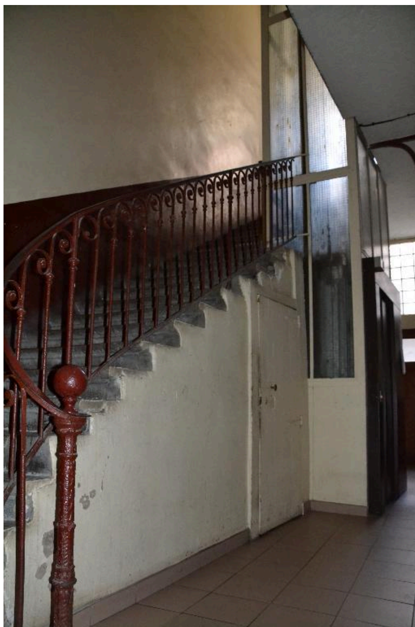
Départ escalier et ascenseur
