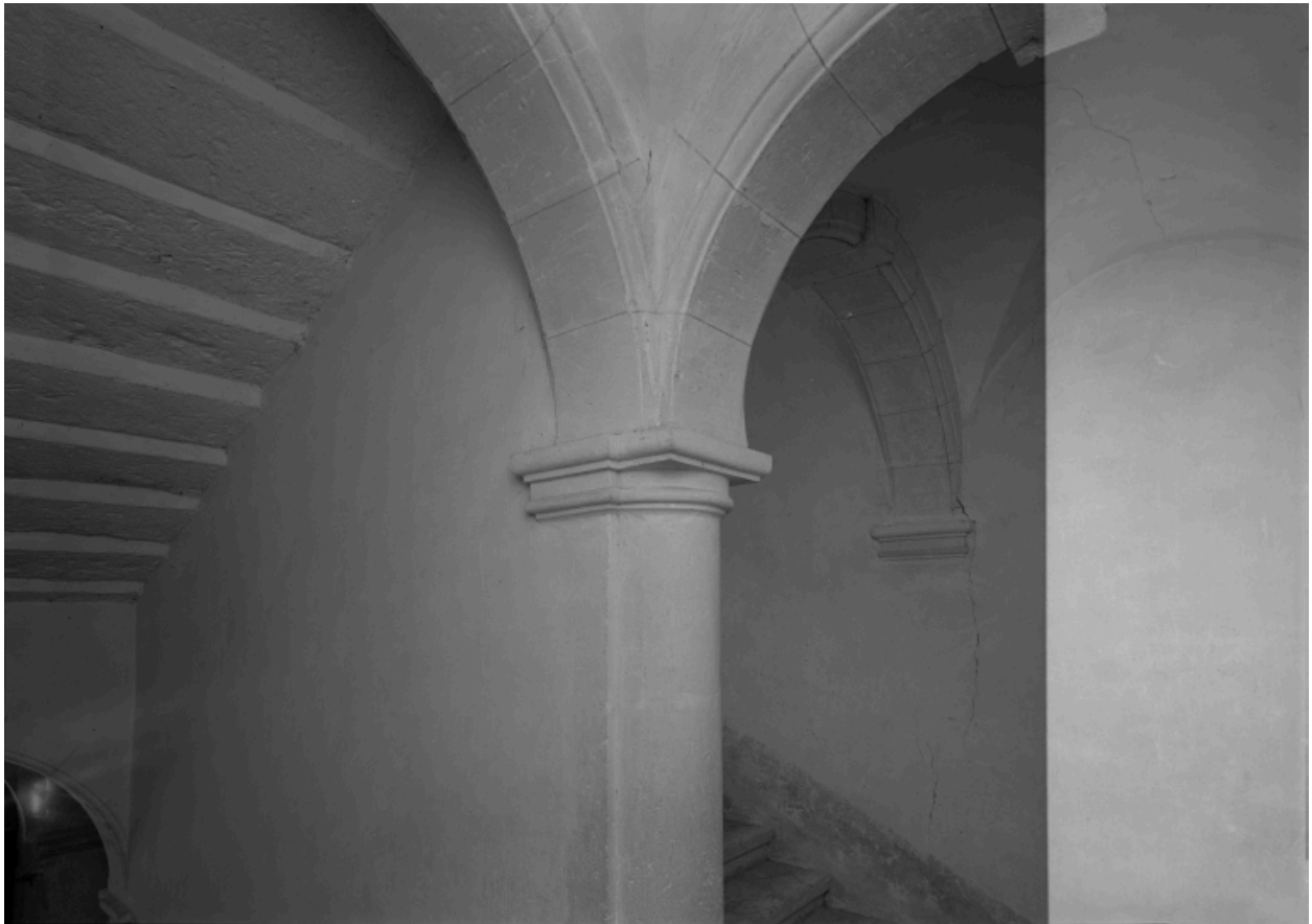
Escalier de l'aile gauche : couverture au niveau du repos.
