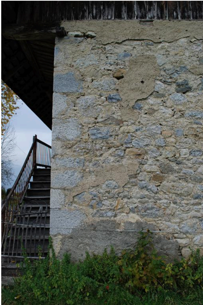
Détail du mur pignon est de la ferme.
