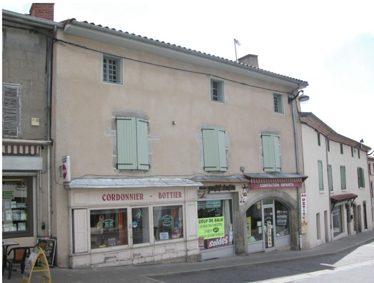
Îlot 9. Carnot (place) 24, 26. Vue générale de la façade sur la place.
