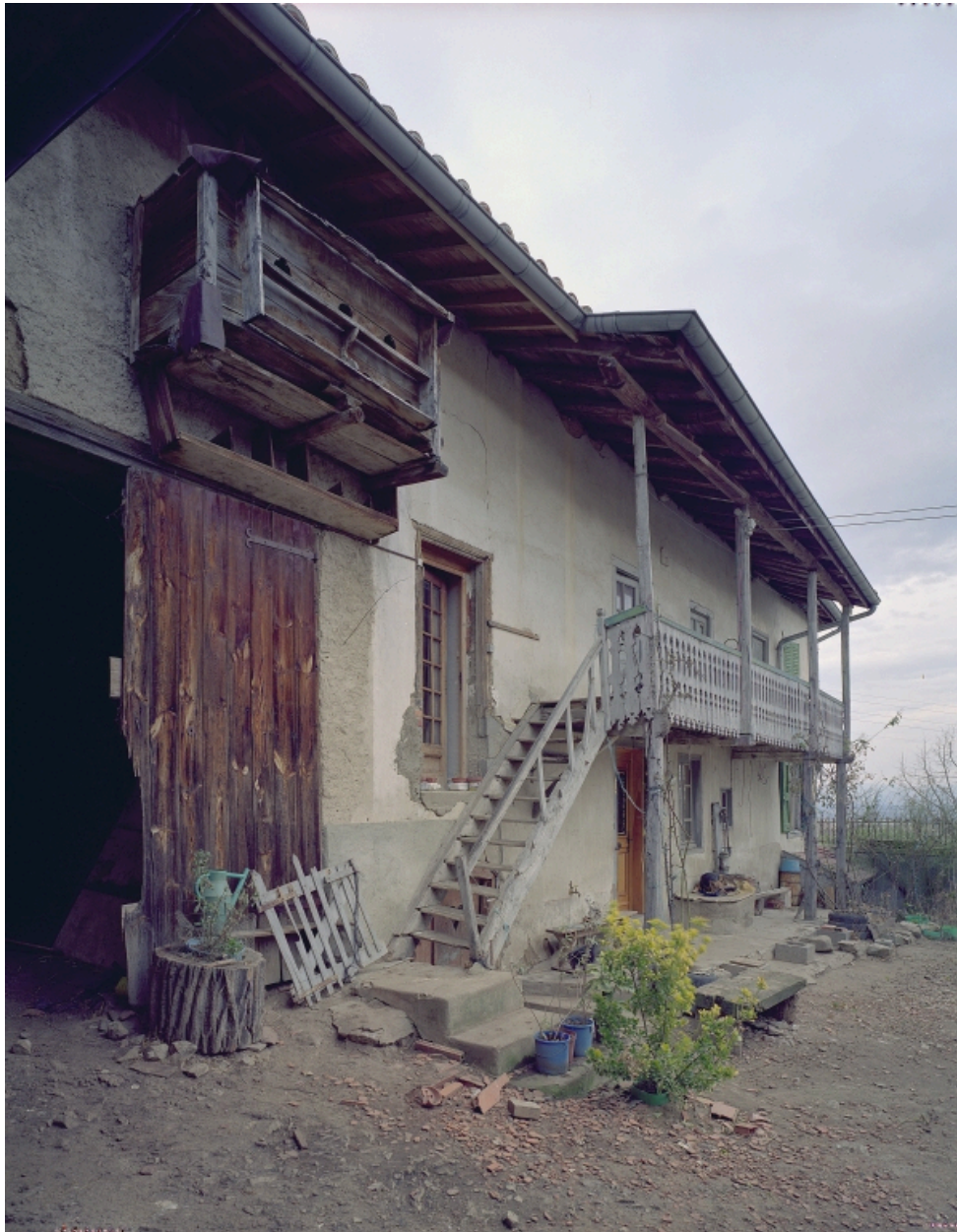
Vue d'ensemble du logis depuis le sud-ouest.
