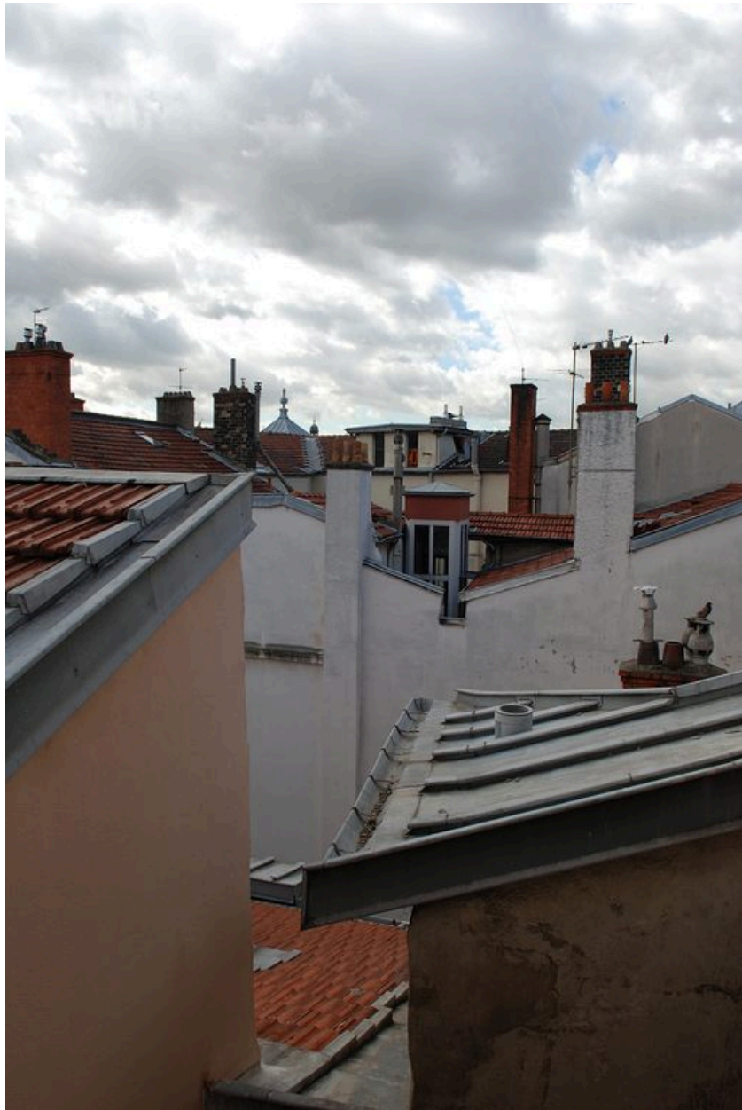
Vue de la toiture depuis le 41 rue de Brest
